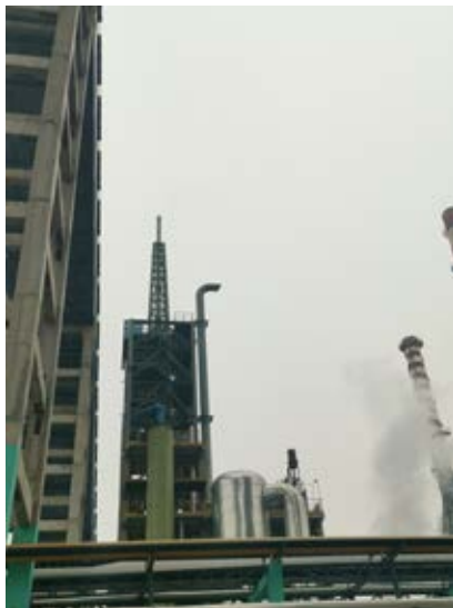
硫回收装置及排气筒
