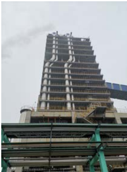
磨煤机尾气排气筒
