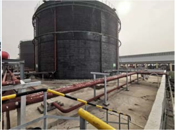
甲醇罐区围堰
