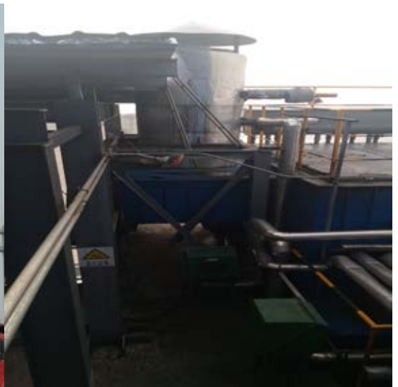
煤筒仓排气筒
