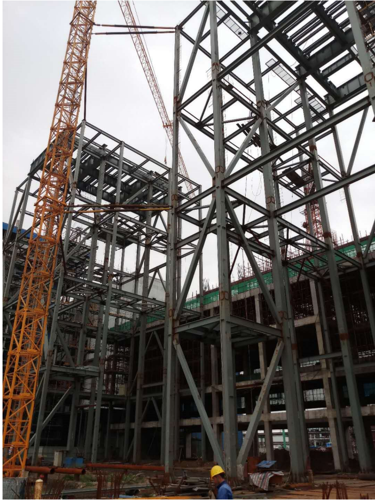
建设中的锅炉节能技术改造项目
